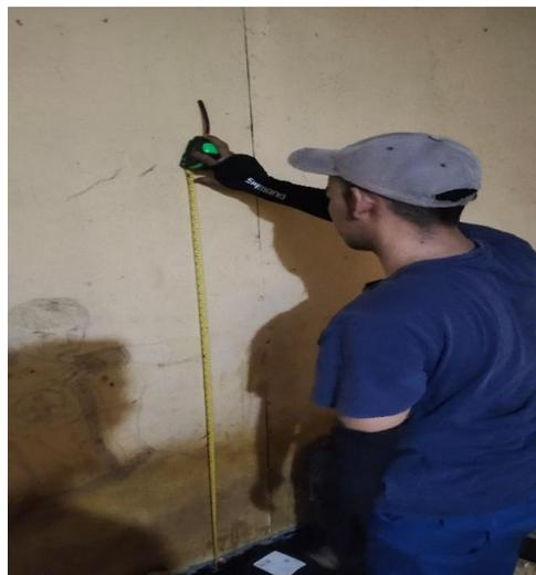
Gambar 3. 1 Pengukuran Ketinggian Unit Indoor
